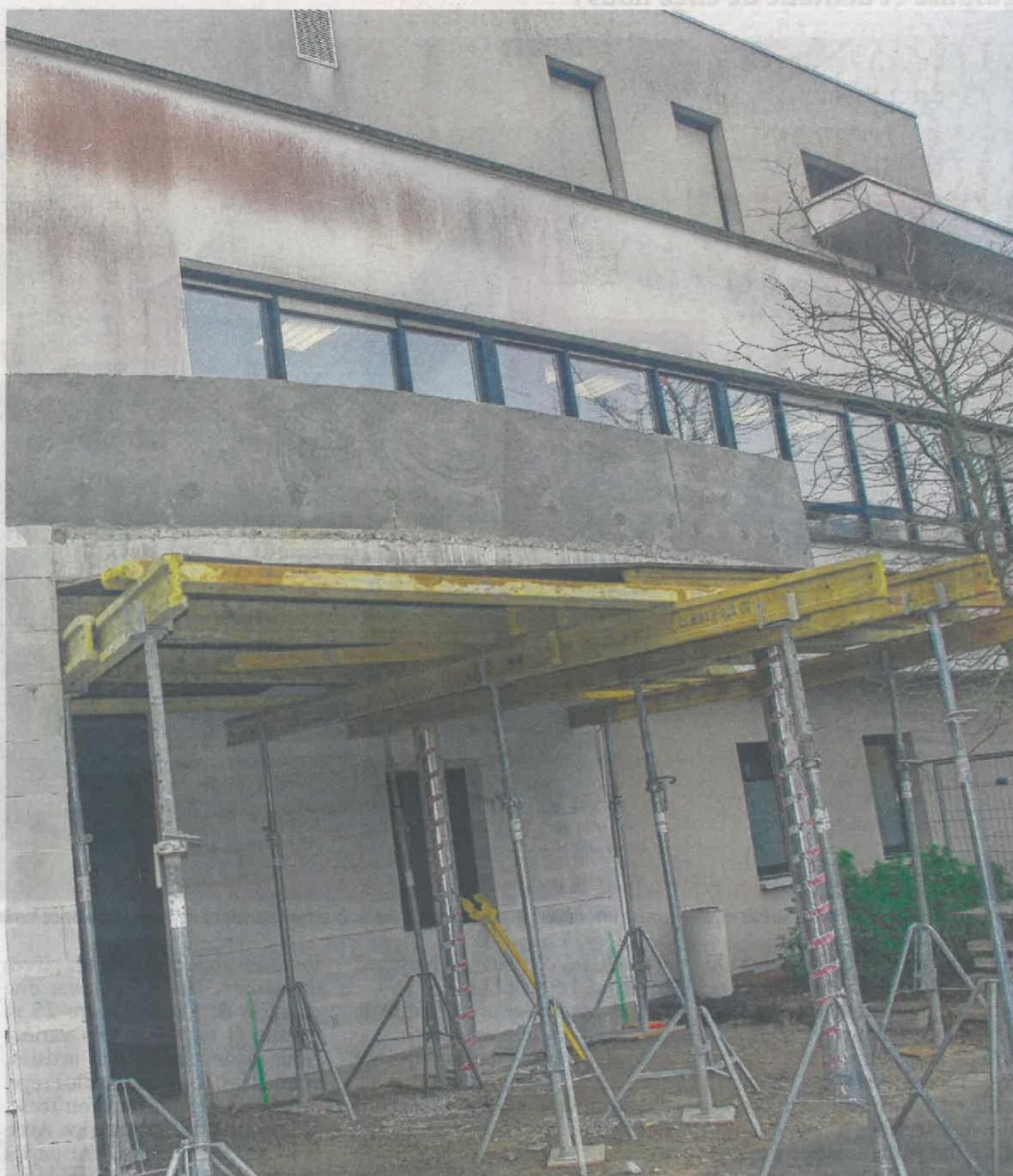
Une extension qui s'intègre parfaitement à l'architecture du bâtiment...
